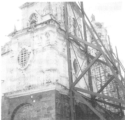
写真3 La Compania 教会鐘塔転倒防止工事
