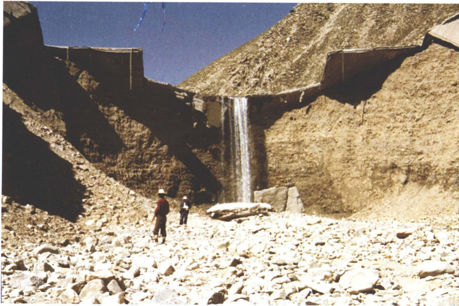
写真-2.1 決壊後の溝后ダム 5)
