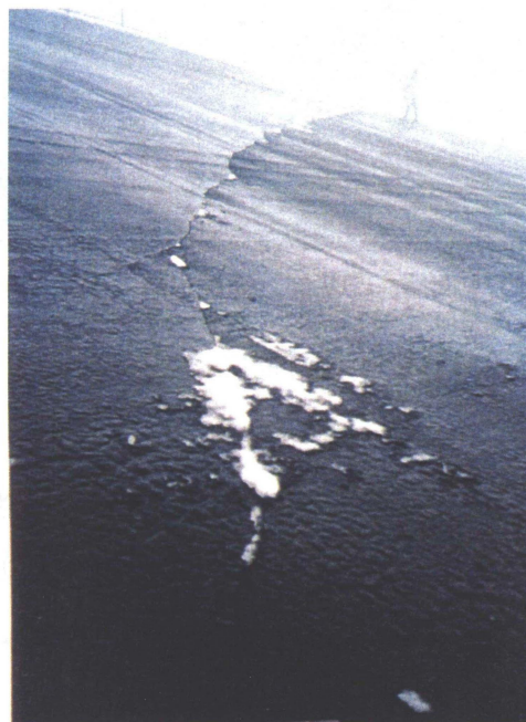
写真-2.9 地震直後に観察されたアスファルト遮水壁の斜め亀裂 (1996年3月8日撮影)
