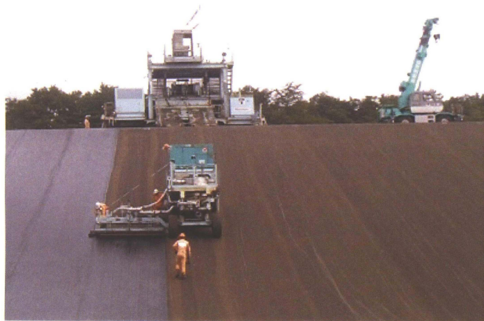
付写真-7 表面保護層工の施工状況
