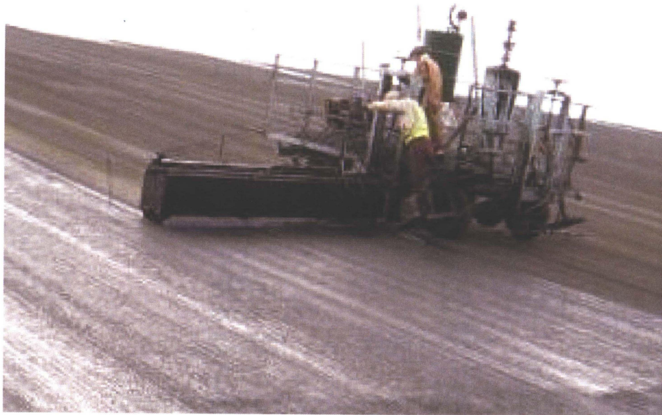
付写真-5 タックコート工の施工状況
