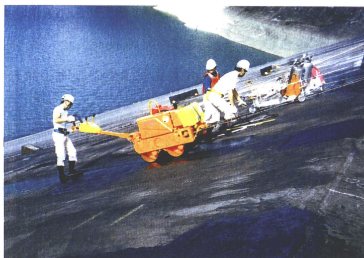
写真-2.4 新規混合物による打換え
