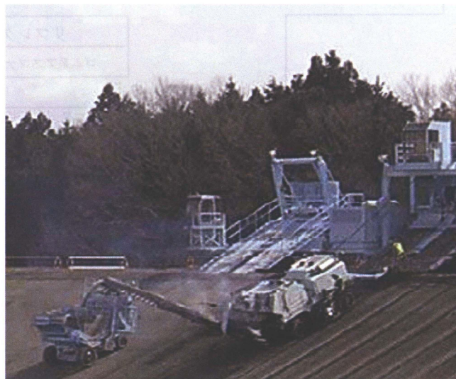
付写真-1 切削工の施工状況
