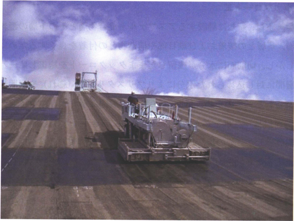
付写真-4 乾燥工の施工状況
