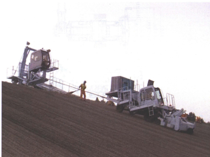
付写真-2 乾式清掃工の施工状況
