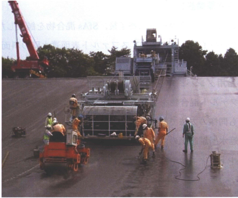
付写真-6 舗設状況
