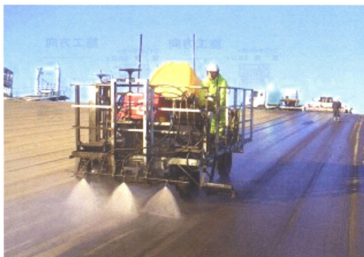
付写真-3 高圧水洗浄工の施工状況
