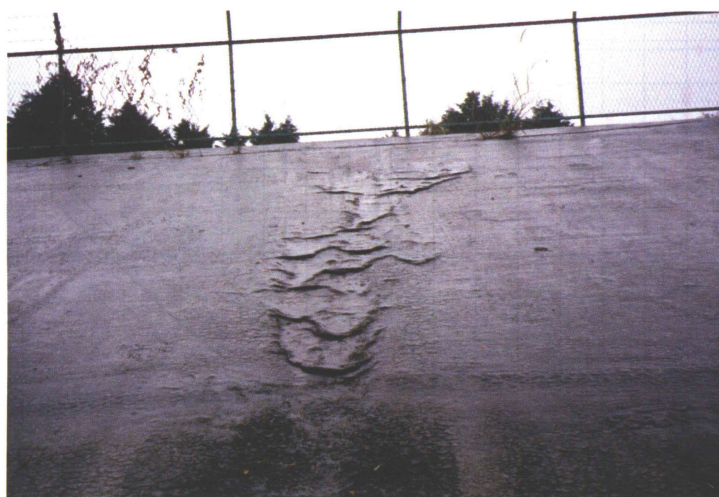
写真-2.6 遮水層のスロープフロー
