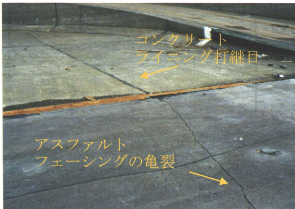
写真-2.13 コンクリートライニングの打継目により生じた亀裂(A-32)
