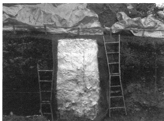
図2 整形した面にネットを貼ってその上から接着剤を塗布（中央白色部）
