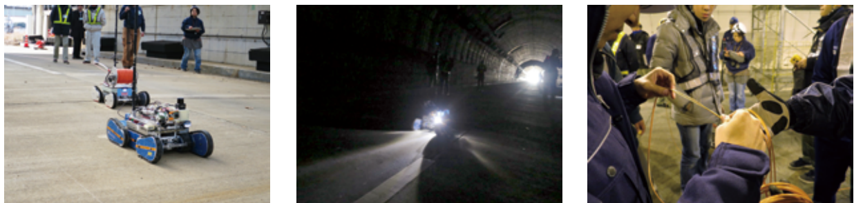
図3：左／中 プラトーン走行および調査ロボットの無線通信走行の様子、右：障害箇所と一部裂けたケーブル
