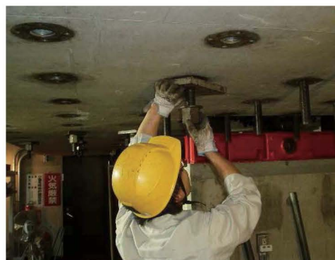
[写真3] ナットの仮締め
