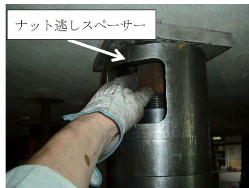
[写真11] ナットの締め付け
