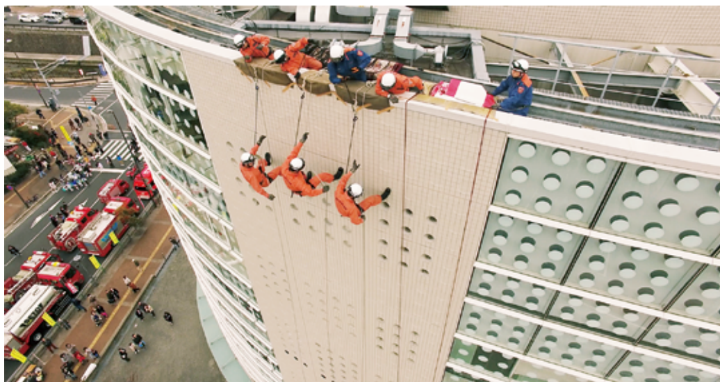
写真3 ドローンからの撮影画像
