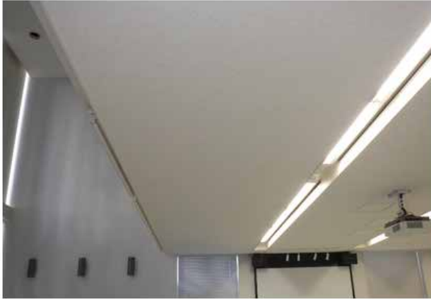
図2. 奥から1列目の既存天井を残した施工例（施工前と施工後）
