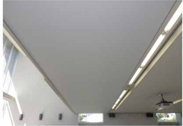
図2. 奥から1列目の既存天井を残した施工例（施工前と施工後）
