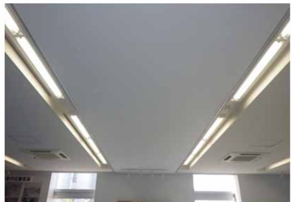
図3. 奥から4列目の既存天井を撤去した施工例（施工前と施工後）
