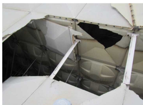
(a) 熊本市，地上水槽，FRP 製 (1981 年設置)
