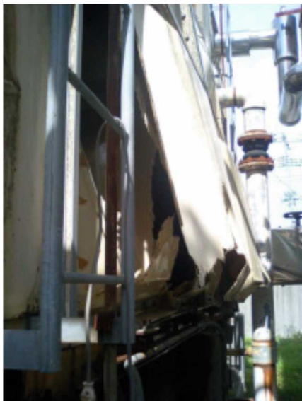
(a) 仙台市，受水槽，FRP 製 （設置年不明）
