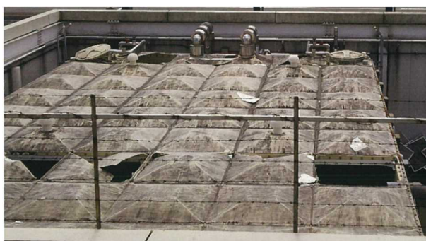
(b) 上益城郡，地上水槽，FRP 製 (1999 年設置)
