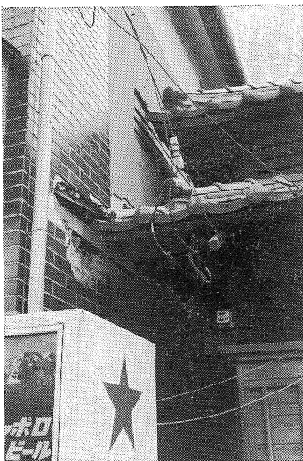
14. 田牛における家屋の接触被害
