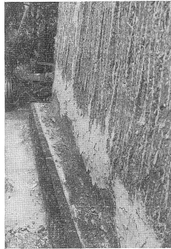
15. 田牛における土蔵のずり被害
