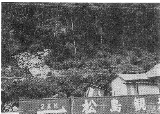
写真7. 高城の斜面崩壊
