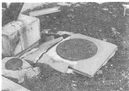
写真-17 屋外階段基礎部の沈下
