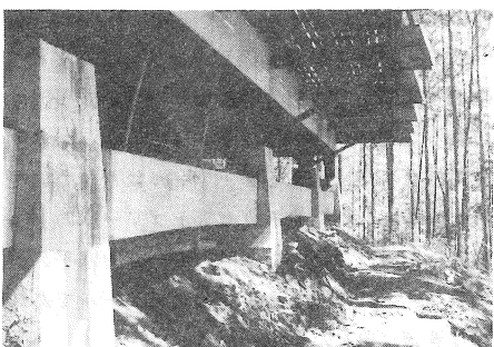
写真-20 南面基礎の状況
