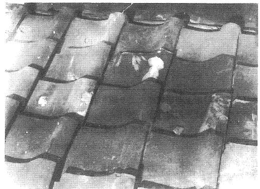
写真1 屋根瓦の腐蝕
